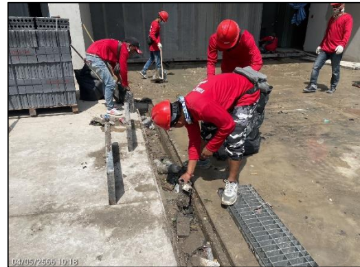
ภาพที่ 32 กิจกรรมขุดลอกตะกอนรางระบายน้ำ
