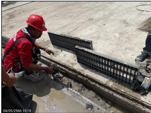
ภาพที่ 32 กิจกรรมขุดลอกตะกอนรางระบายน้ำ
